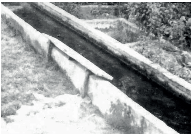
Fig. 80. Lavatoio sul canale
