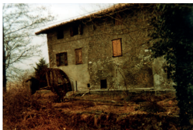
Fig. 78. Cana del mulino in calcestruzzo
