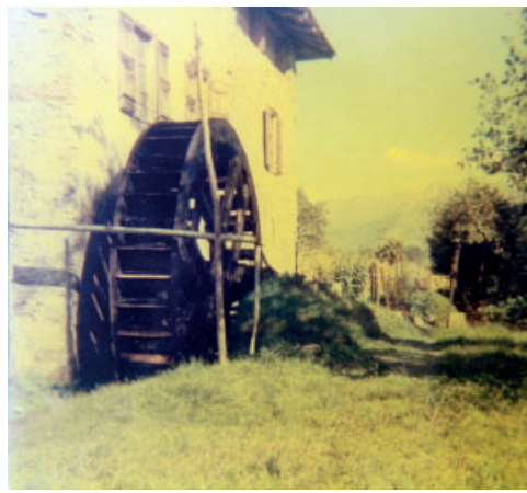
Fig. 82. La ruota era molto grossa, con pale a cassetta e veniva mossa dal basso
