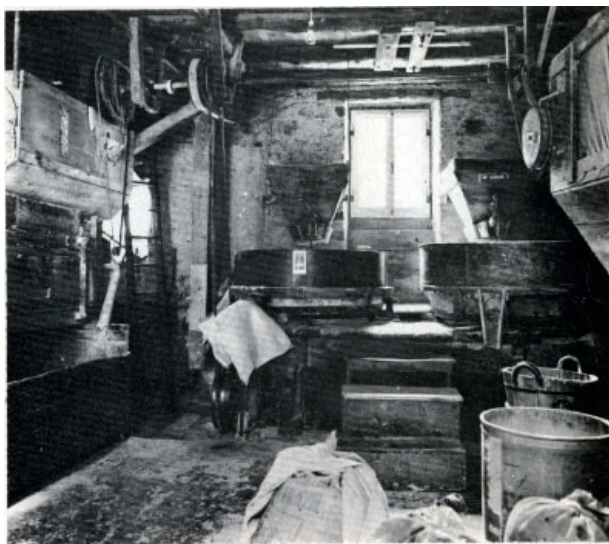
Fig. 113. Interno del mulino Bertoletti prima del restauro
