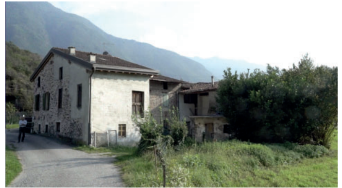
Fig. 111. A sinistra l'edificio col mulino dei Bertoletti e a destra quello dei Sigala
