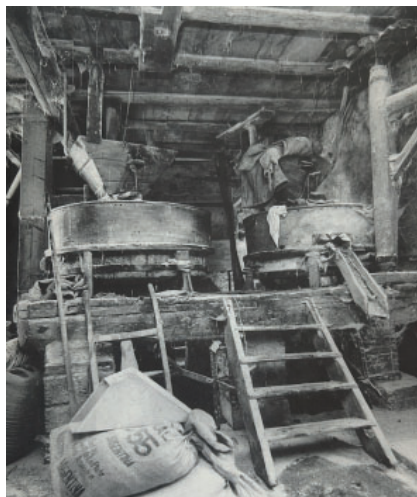
Fig. 84. Mulino Sigala di Erbanno: si vede il soppalco con sopra due coppie di macine
