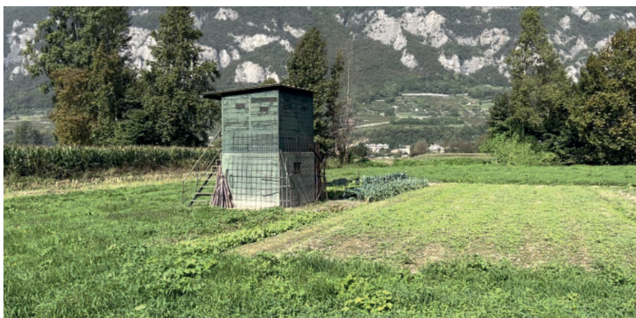
Fig. 56. Capanno nei pressi dell'Ogliolo ad Angone
