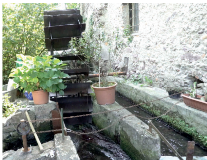
Fig. 116. La saracinesca viene spostata tramite una catena manovrabile dall'interno e lascia passare l'acqua del canale
