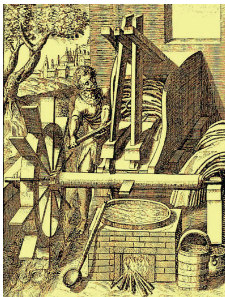
Fig. 2. Esempio di follone, illustrato da Strada nel XVII secolo: l'albero di una ruota mossa dall'acqua mette in azione un maglio che batte sui panni (foto tratta da Internet)
