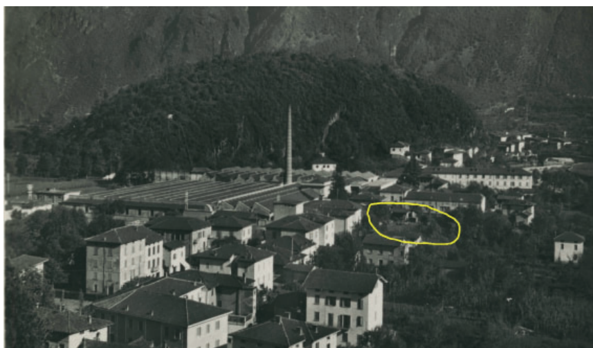
Fig. 125. Nel cerchio si vede la zona in cui vi era la segheria Vela
